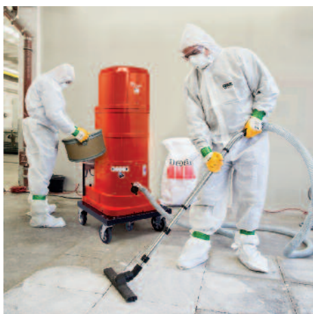
DS 2520 AH (asbest, dammklass H) i asbestsanering
