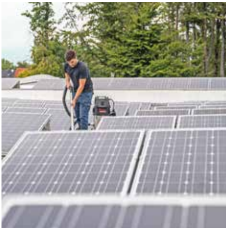
R18 D Rengöring mellan solcellspaneler
