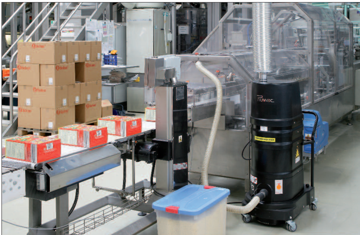
Figure 9, Aspiration, mise en oeuvre de dépoussiéreurs portatifs
