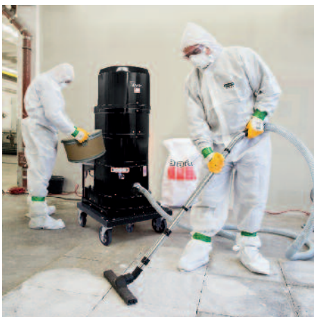
DS 2520 AH (amiante, classe de poussière H) dans le désamiantage
