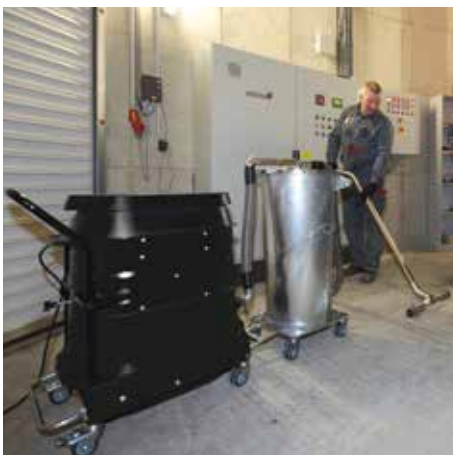
R01 A020 con separador previo en la central de calefacción
