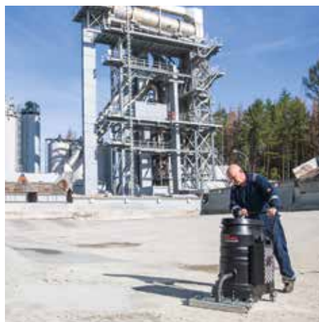
R01 D põranda imemisseadmega asfalditehases
