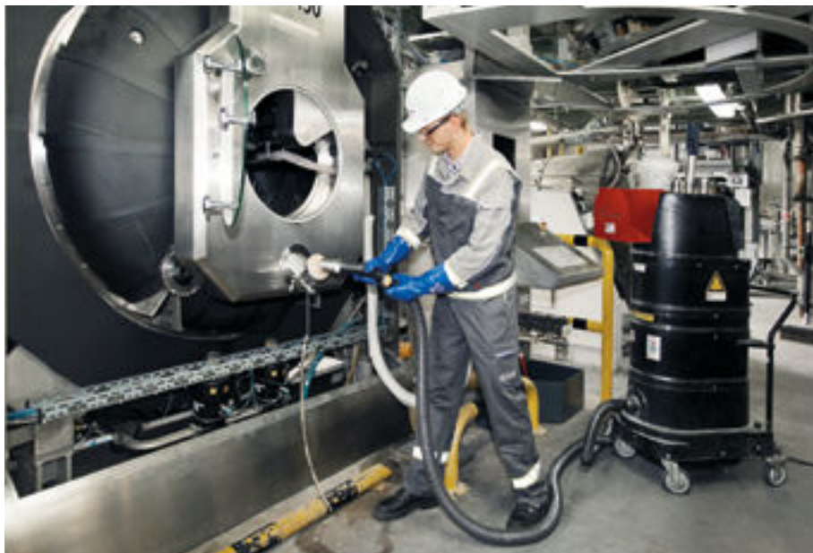
Bild 3: Typische Aufgabe von Gas-Ex-Saugern: Reinigung an Reaktionsbehältern. Das Saugerhäuse wird aus GFK gefertigt.
