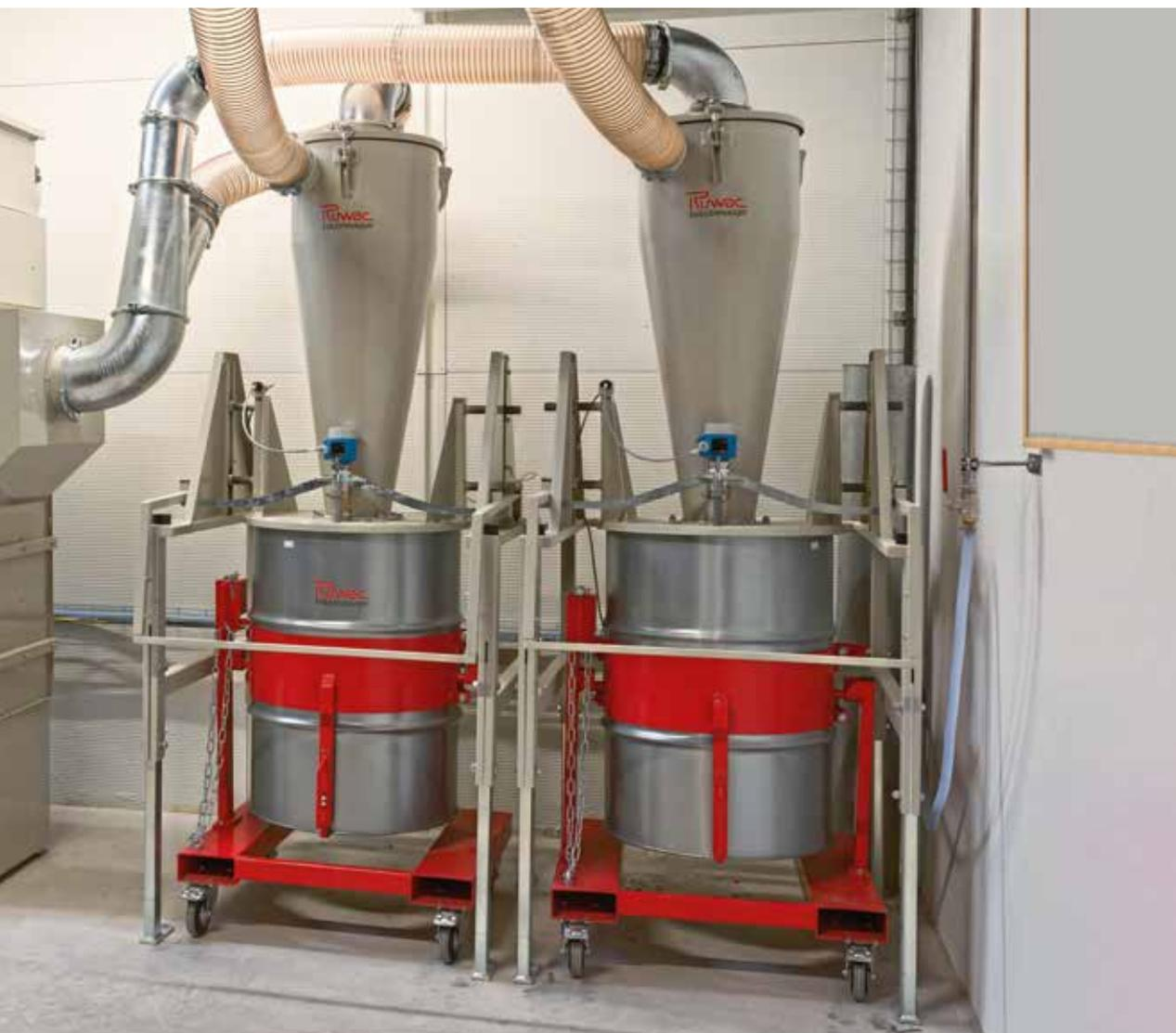
Größere Absauganlage in der Kunststoffproduktion mit zwei Vorabscheidern (rechts), Filtereinheit (Mitte) und Antriebsaggregat (links).
