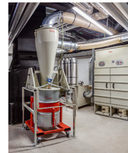
Bei einer der beiden Absauganlagen übernehmen zwei modulare Entstaubungseinheiten der Serie DS6 (rechts) die Filtration. Im Vordergrund: der Zyklonabscheider für die Vorabscheidung von Kunststoffpartikeln. © Ruwac
